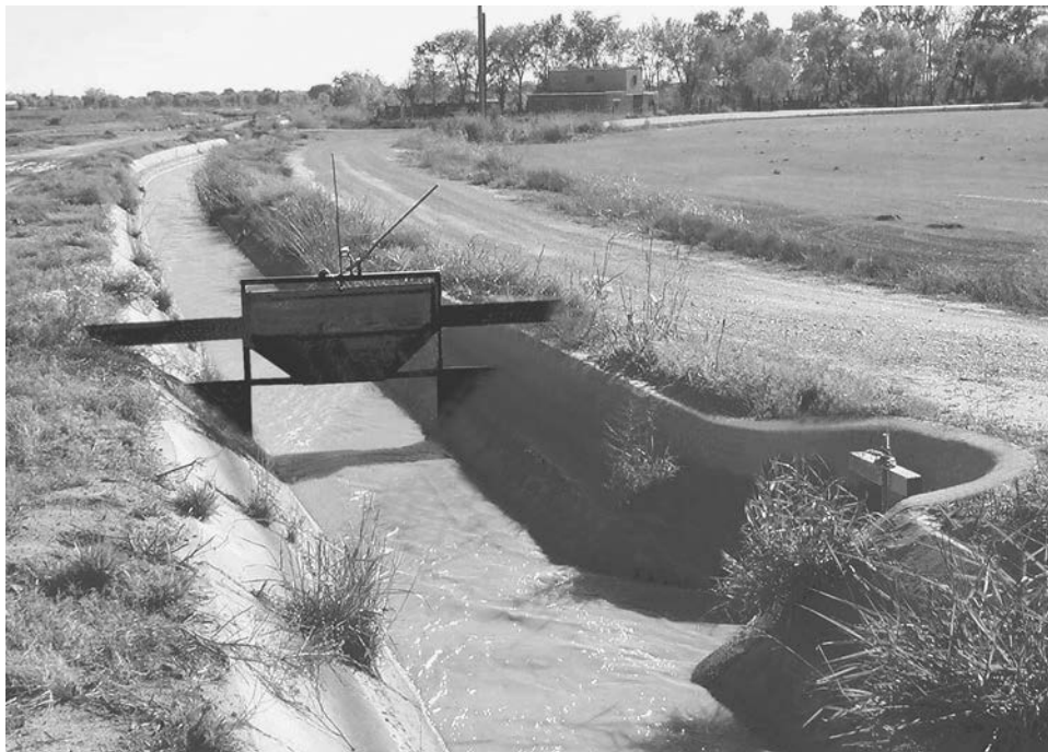
La estructura metálica de la izquierda es un retén. Cuando está cerrado, el agua en el canal de la línea alta o en el lateral se acumula hasta un nivel que fluirá a través del desvío, como se muestra en la parte inferior derecha, hacia un campo agrícola o una zanja más pequeña. Photograph by Anders Lundahl
